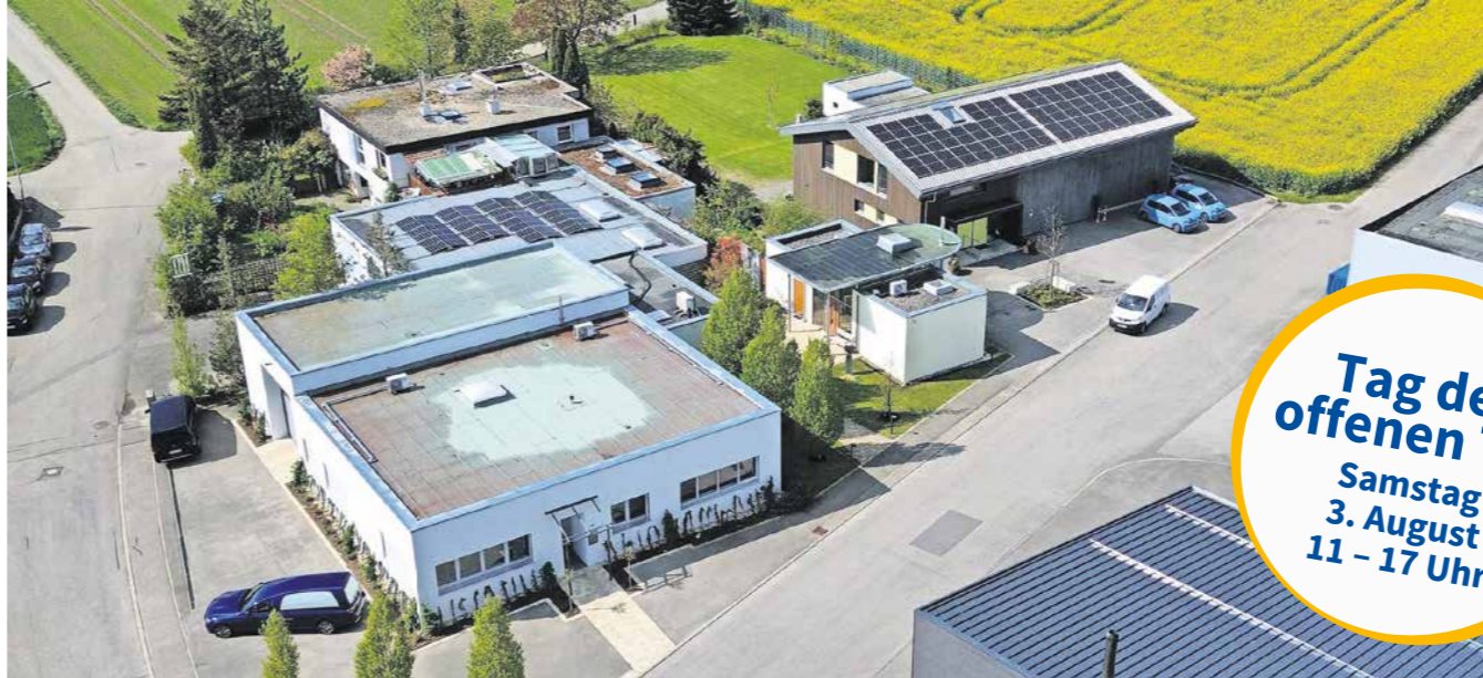
Rund einhalb Jahre wurde der Hauptsitz von Weiß & Mozer in Jettingen modernisiert.
